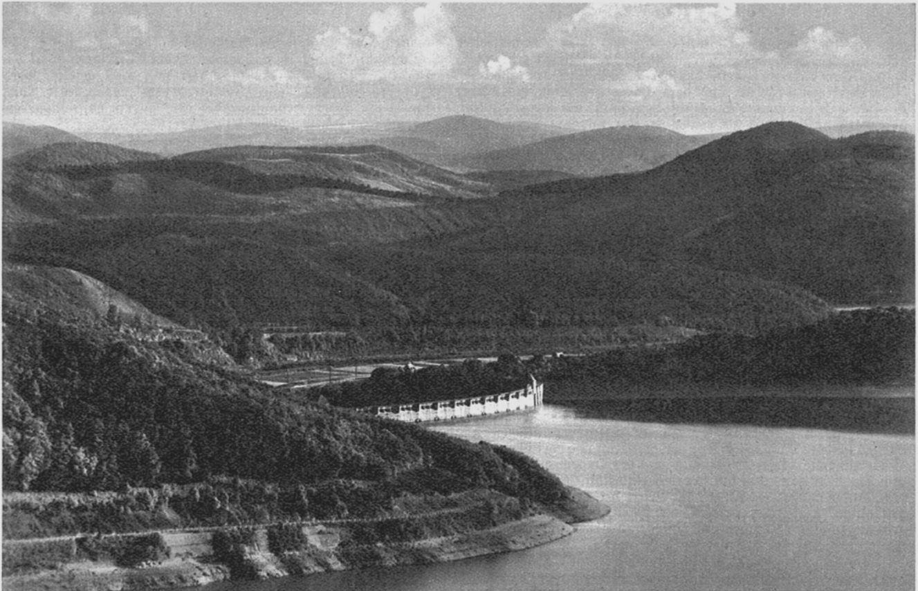
Die Industrie und das damit verbundene Anwachsen zahlreicher Städte zwang uns, Talsperren zu bauen, hinter denen sich gewaltige Wassermengen ansammeln, um dann die Turbinen von Elektrizitätswerten zu treiben oder die Städte mit Wasser zu versorgen. So schuf der Mensch herrliche Seenlandschaften, wie den hier abgebildeten Edersee in der Nähe des weltberühmten Bades Wildungen. Er ist einer der größten Stauseen Europas und faßt 202 Millionen Kubikmeter Wasser
